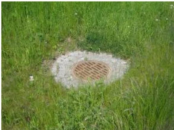
**Abb. 16** Entwässerungsmulde an der nördlichen Straßenseite der L 286 mit Entwässerungsgulli
